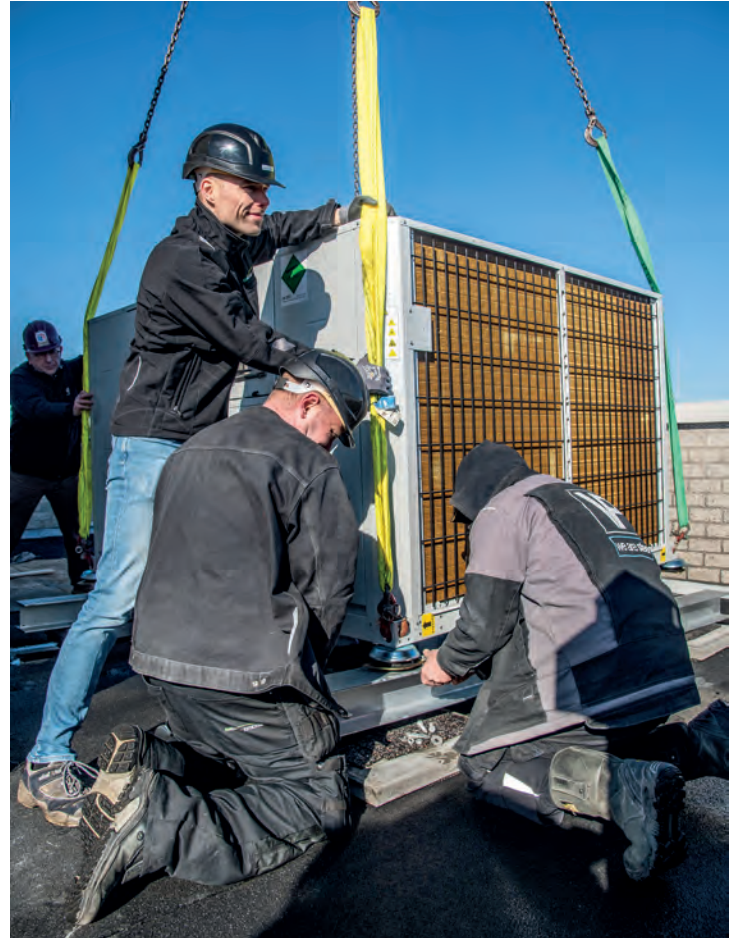
Precisieklusje: het positioneren en fixeren van de Carrier warmtepomp van 70 kW. Deze lucht/water-warmtepomp moet de hoofdverwarmer worden.
