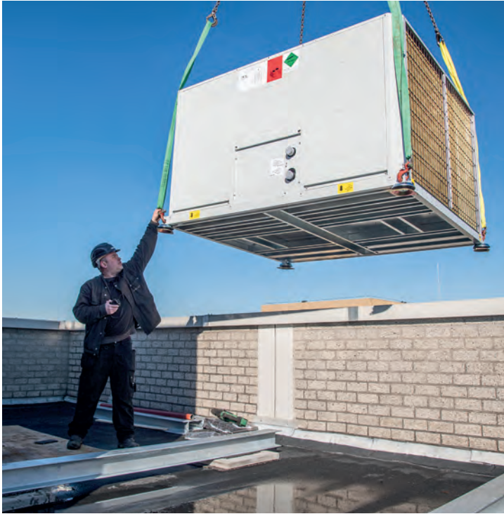
Precisieklusje: het positioneren en fixeren van de Carrier warmtepomp van 70 kW. Deze lucht/water-warmtepomp moet de hoofdverwarmer worden.
