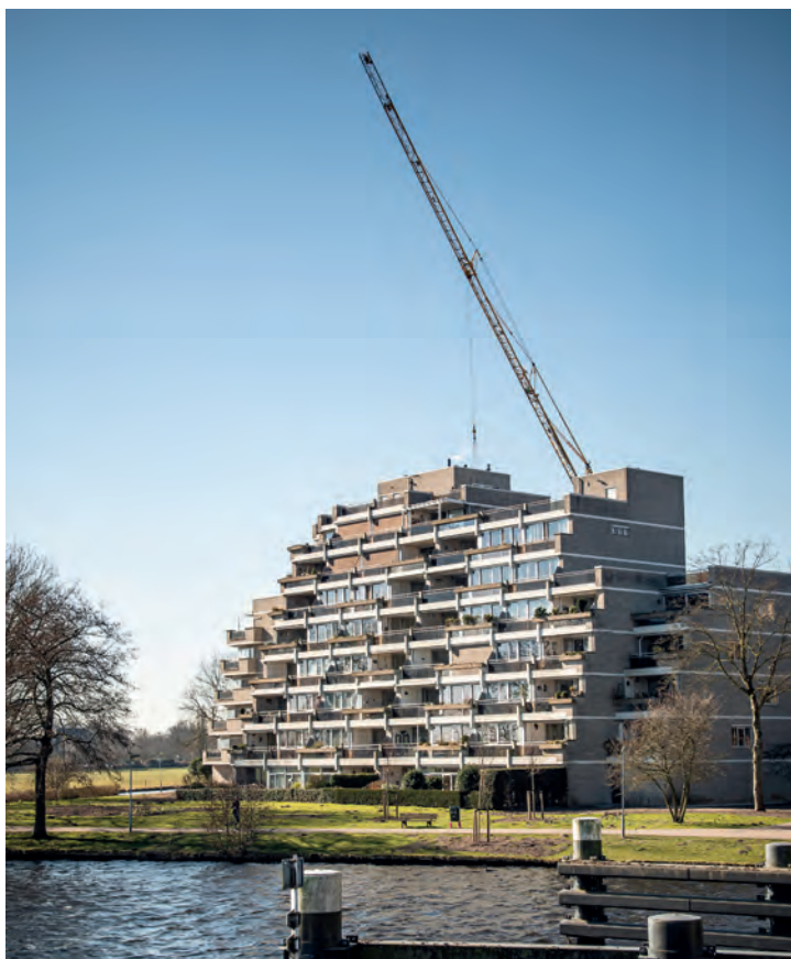
De warmtepomp wordt met een hijskraan op het appartementencomplex gehesen.
