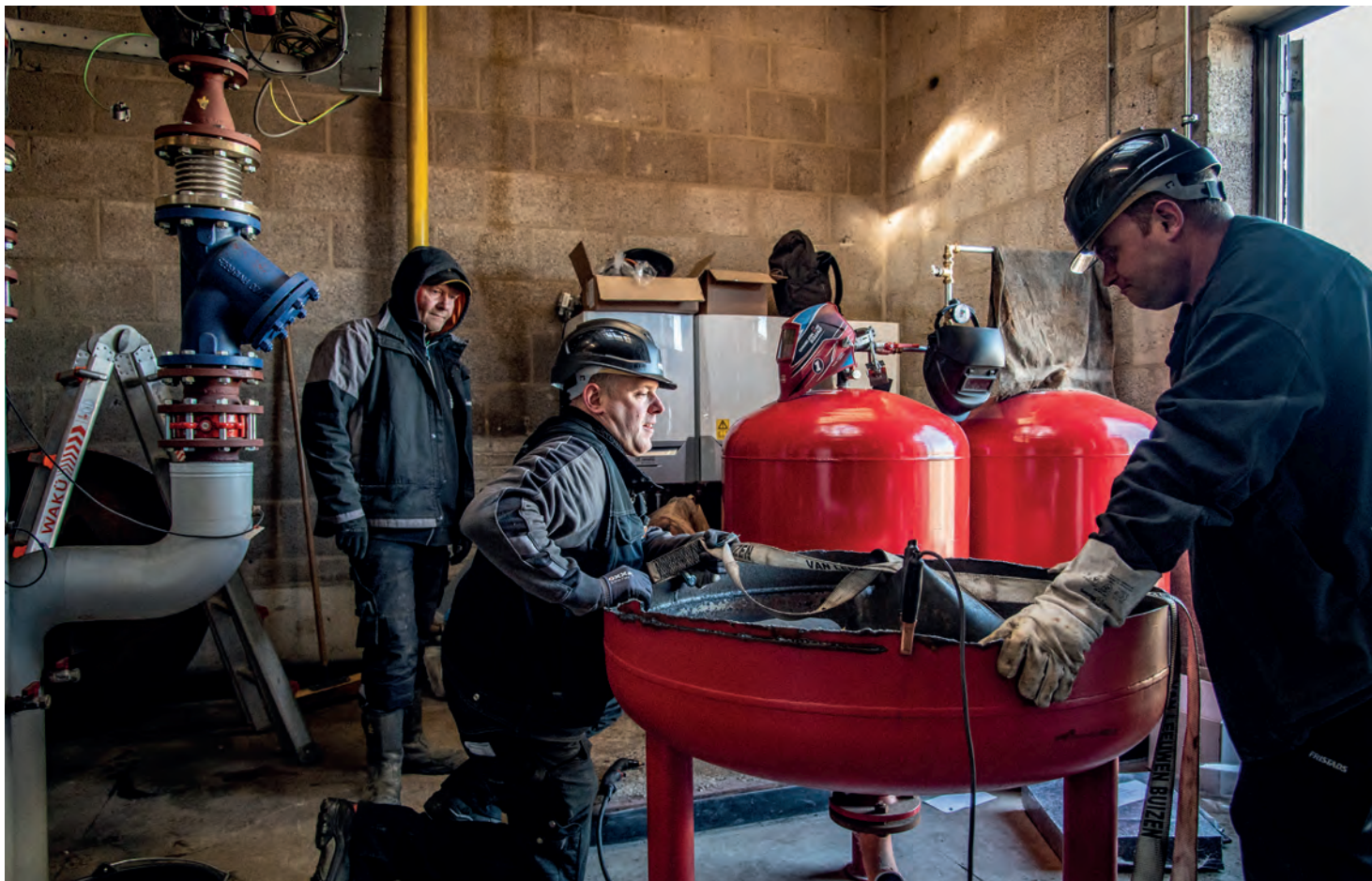
De bestaande installatie wordt gedemonteerd en verwijderd uit het ketelhuis.
